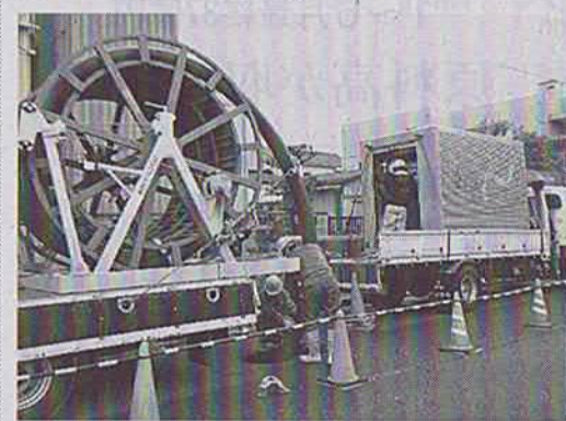
下水管の改修工事。マンホールから補強する樹脂管を入れる(神戸市での工事)
